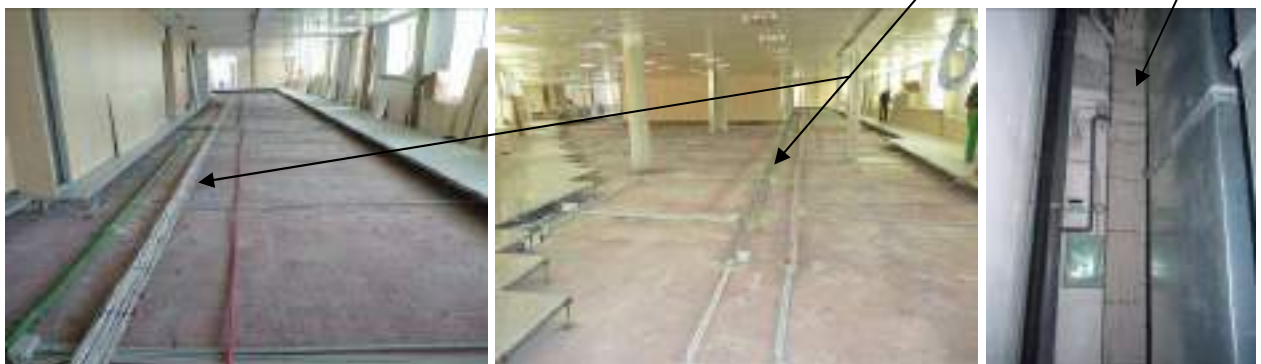
Fotos 104-106: Conducciones Electricidad-Telecomunicaciones (falso suelo) (patinillo):
