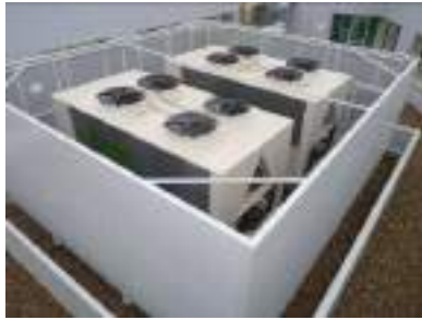
Módulo Hidráulico enfriadora integrada
