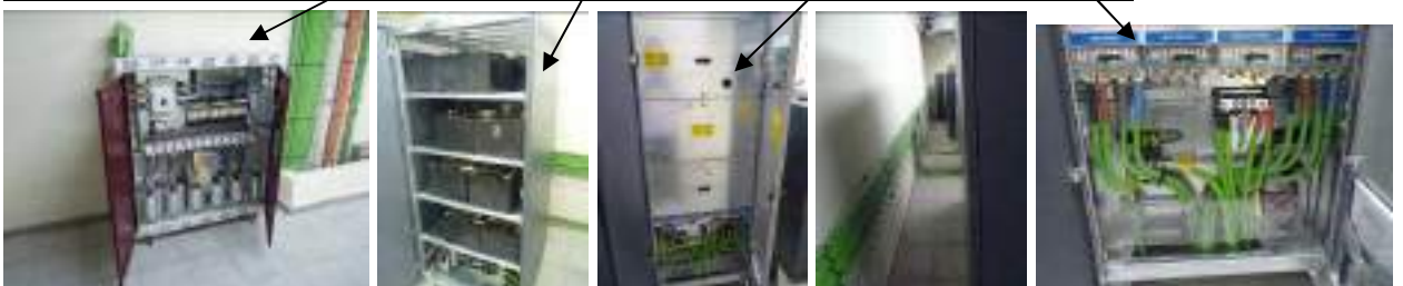
Fotos 95 a 99: Bat. Condensadores, Baterías y componentes equipos SAI;
