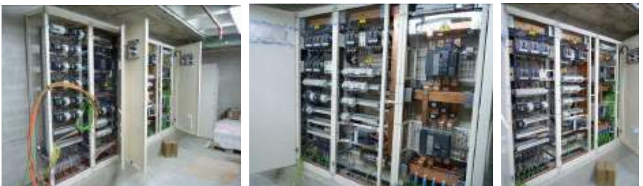
Fotos 95 a 99: Bat. Condensadores, Baterías y componentes equipos SAI;
