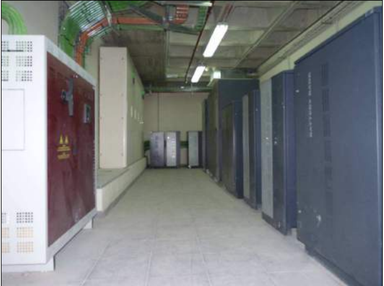
Fotos 92 a 94: Instalación Electricidad: Cuadros Generales; Ejecución durante obra;
