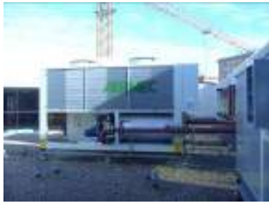
Módulo Hidráulico enfriadora integrada
