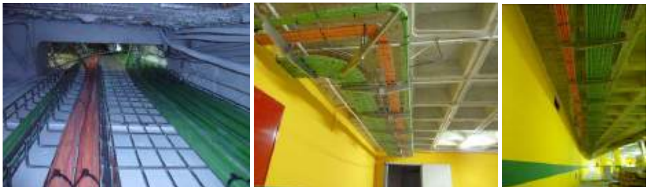
Fotos 104-106: Conducciones Electricidad-Telecomunicaciones (falso suelo) (patinillo):
