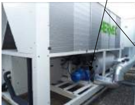
Módulo Hidráulico enfriadora integrada
