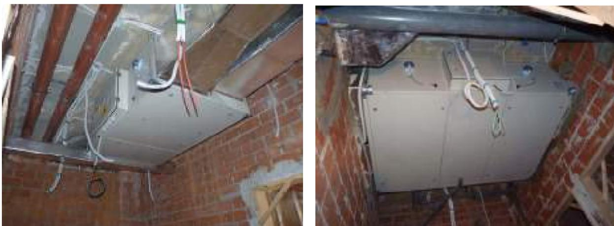
**Foto 52: Instalación Conductos Aislados para Tratamiento de Aire desde Climatizadores.**
