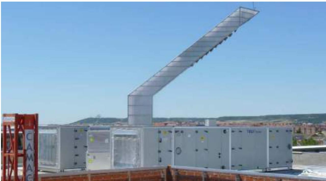
**Fotos 47-49: Climatizadores para aire primario de ventilación. Configuración horizontal en cubierta:**
