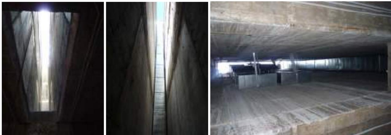
**Fotos 58-59: Interior de conductos de ventilación (Aislados) y extracción Garaje (sin aislar)**
