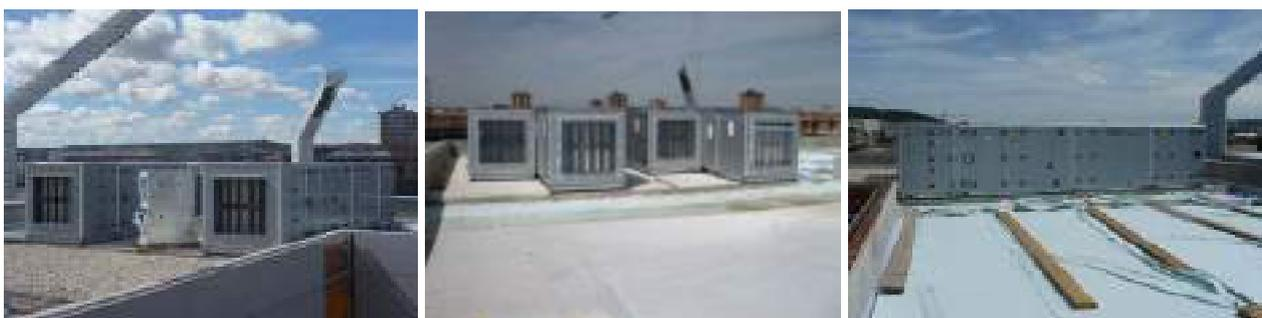
**Fotos 50-51: Instalación de recuperadores entálpicos de energía:**
