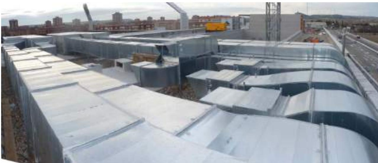
**Foto 53: Instalación de Conductos Aislados para Tratamiento de Aire. Salida de Patinillo**
