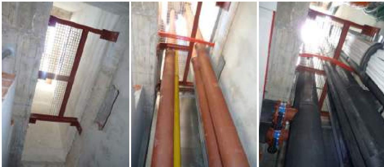
**Fotos 44-45: Tuberías por Interior: Patinillos registrables por planta;**
