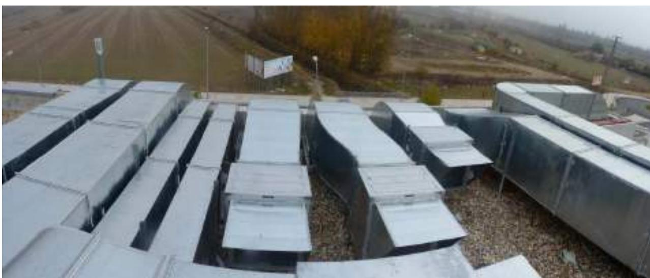
**Foto 54: Vista lateral salida de conductos desde climatizadores a patinillo de conductos**
